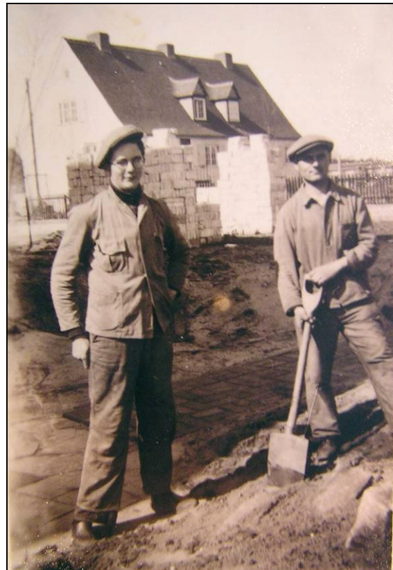
Povl ved anlægsarbejdet i Oderberg. Arbejdsformanden med spaden.
