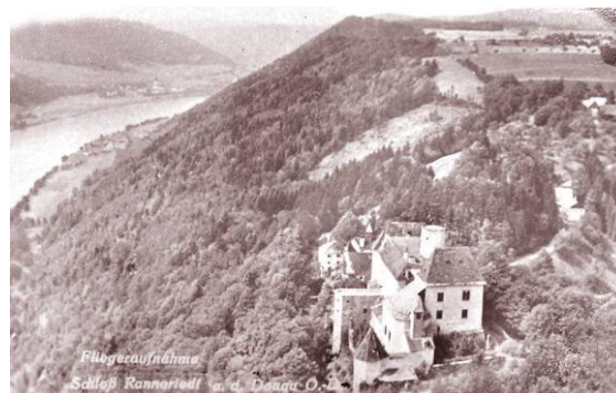
Slottet Rannariedl, hvor Poul og Kaj lavede anlægsarbejde.
