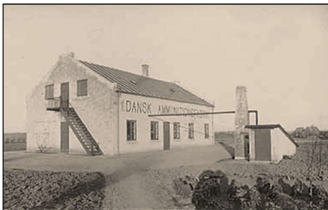
Fabriksbygningen og det fritliggende kedelhus.
